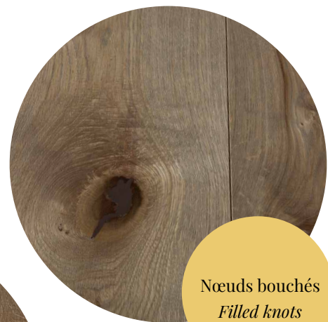
Nœuds & gerces Knots & Cracks
